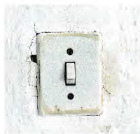
Foto 4: Interruptores en mal estado, existe peligro al usarlos
