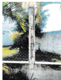
Foto 6: Las columnas del muro perimetral se encuentra debiles y el hierro de la estructura tiene corrosion
